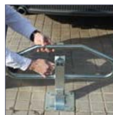
Detall obertura-tancament de la barrera manual per al pas de vehicles.
