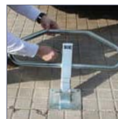
Detall obertura-tancament de la barrera manual per al pas de vehicles.
